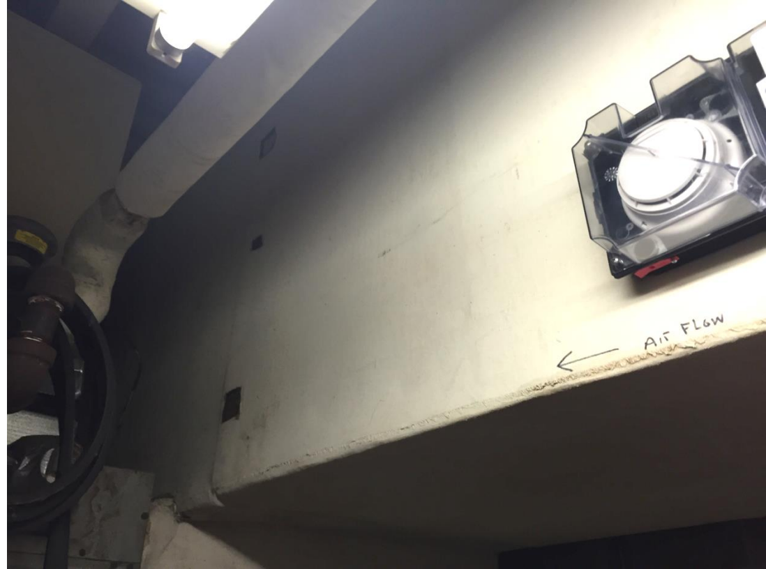
Exhaust Fan System
